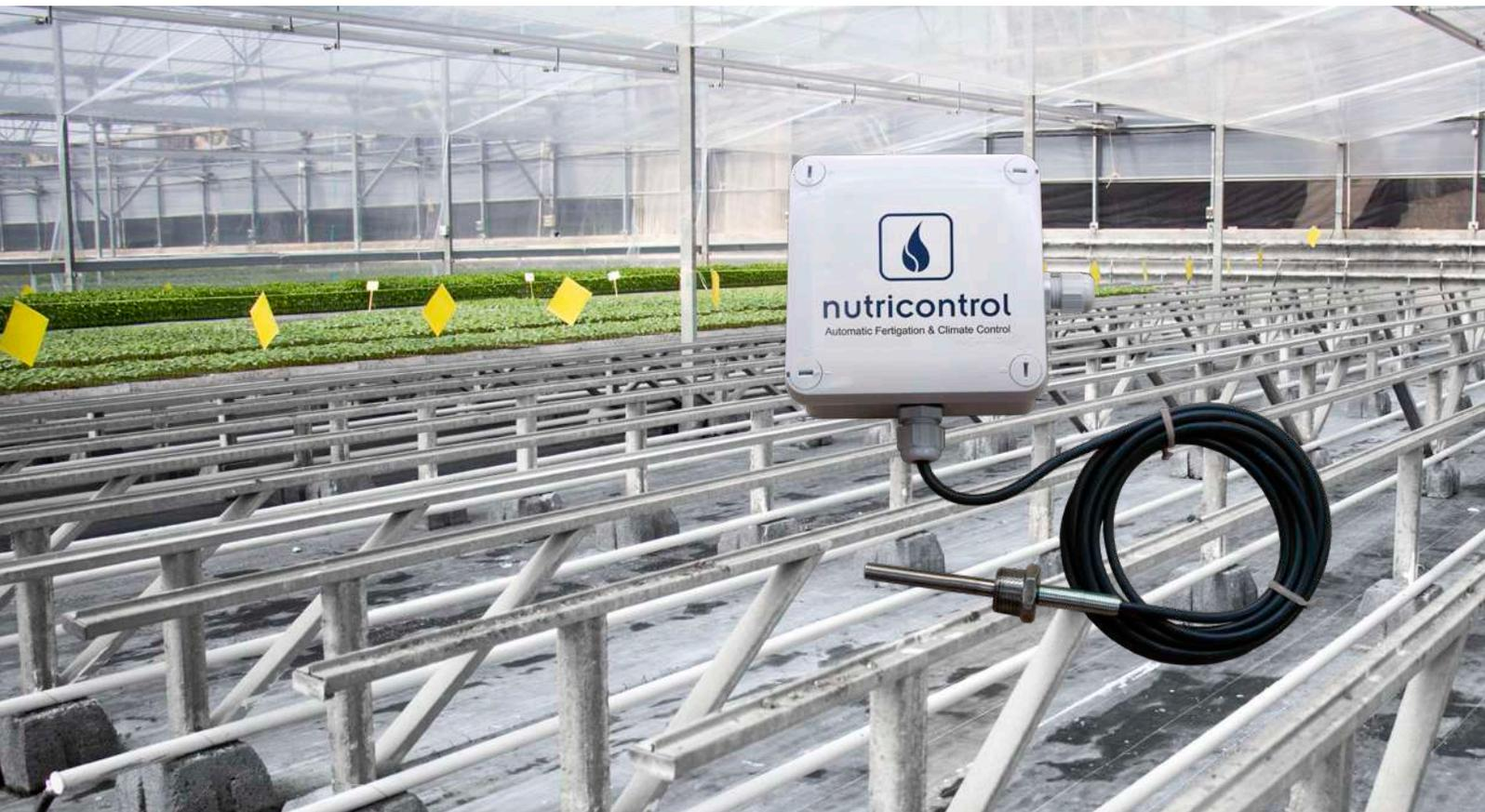
La **sonda de calefacción** mide de forma constante la temperatura del agua en el interior de los anillos de calefacción, así como en los grupos de transporte.
